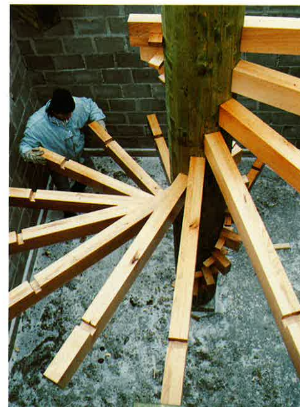
Réception et réglage de la structure bois dans la cage d'escalier.
