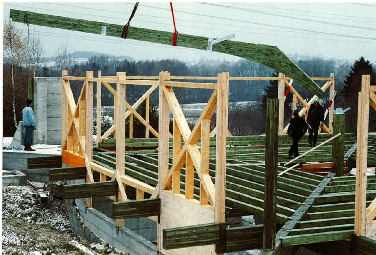
▲ Mise en place de la première ferme lamellée-collée cintrée reposant sur le pilier central et sur le poteau d'angle.
