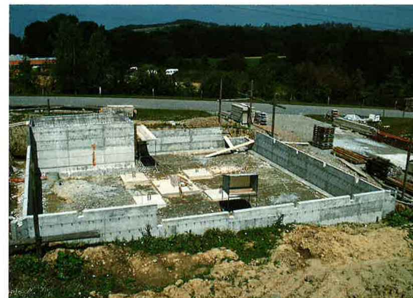
Vue générale des soubassements.
