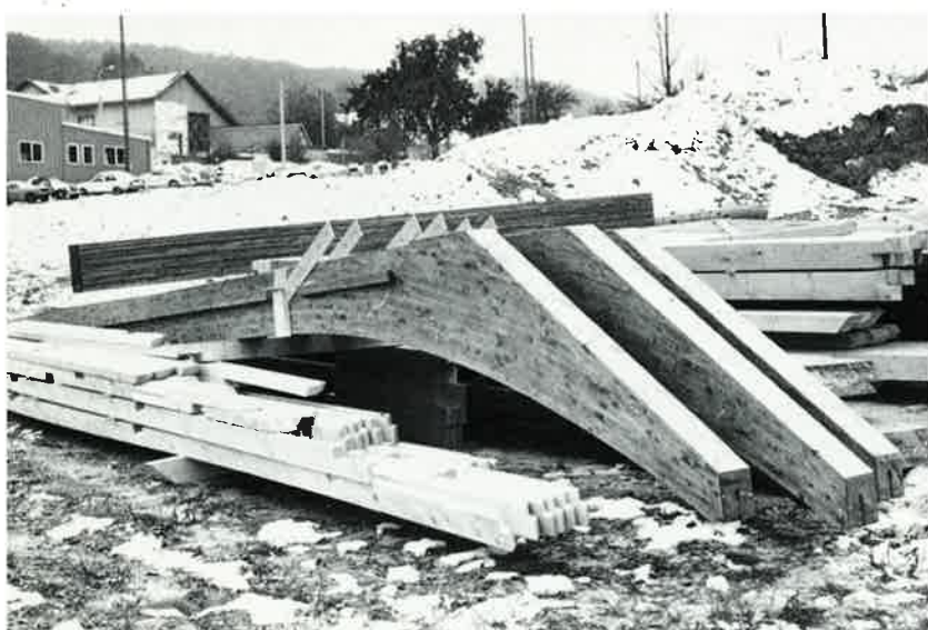
Ordonnancement des pièces préfabriquées sur la place de dépôt en fonction du montage.
