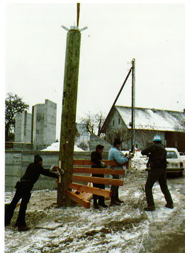
Introduction des supports de marches d'escalier en chêne dans le pilier central lamellé-collé.
