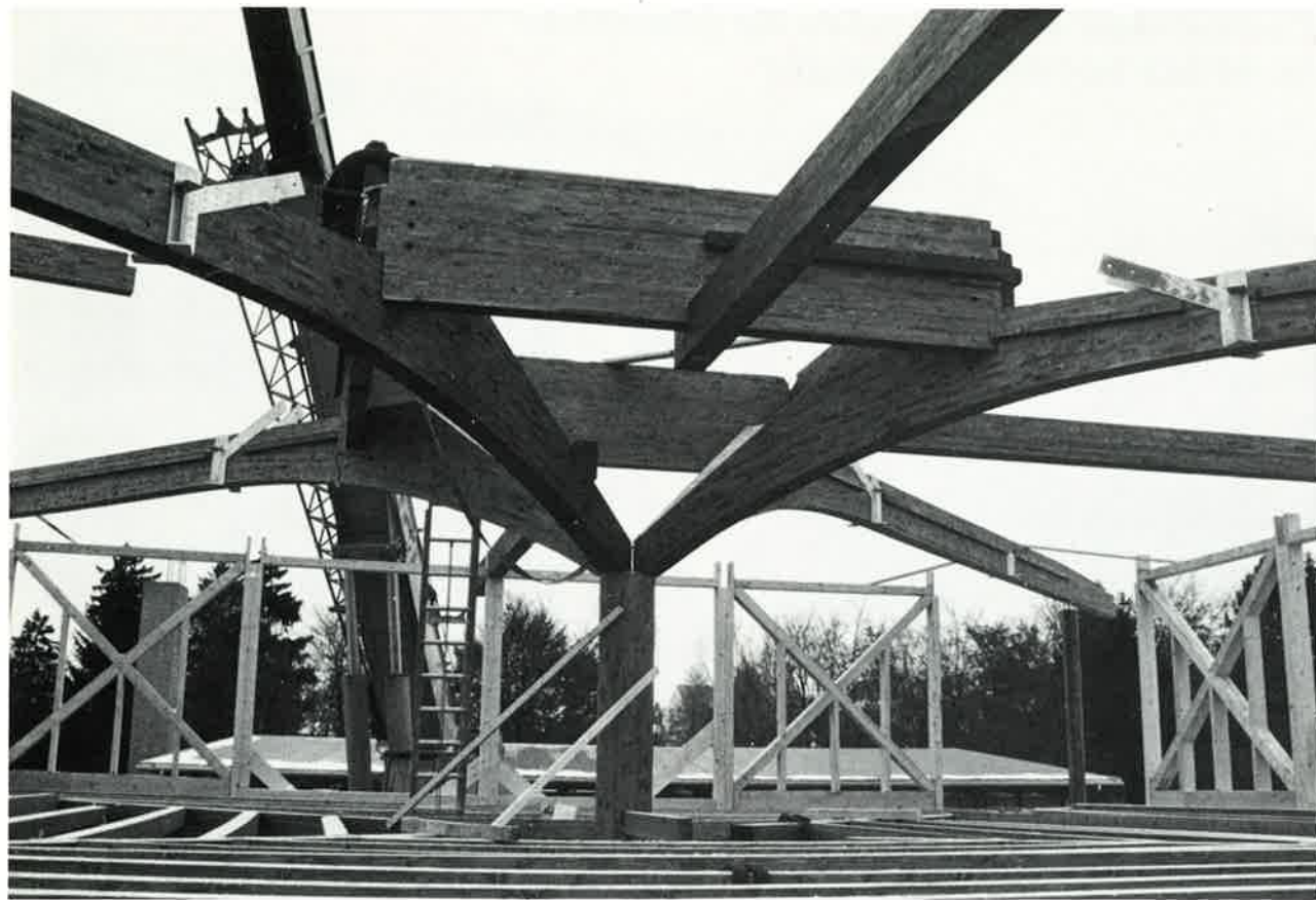
Cadre de répartition des éléments de toiture.
