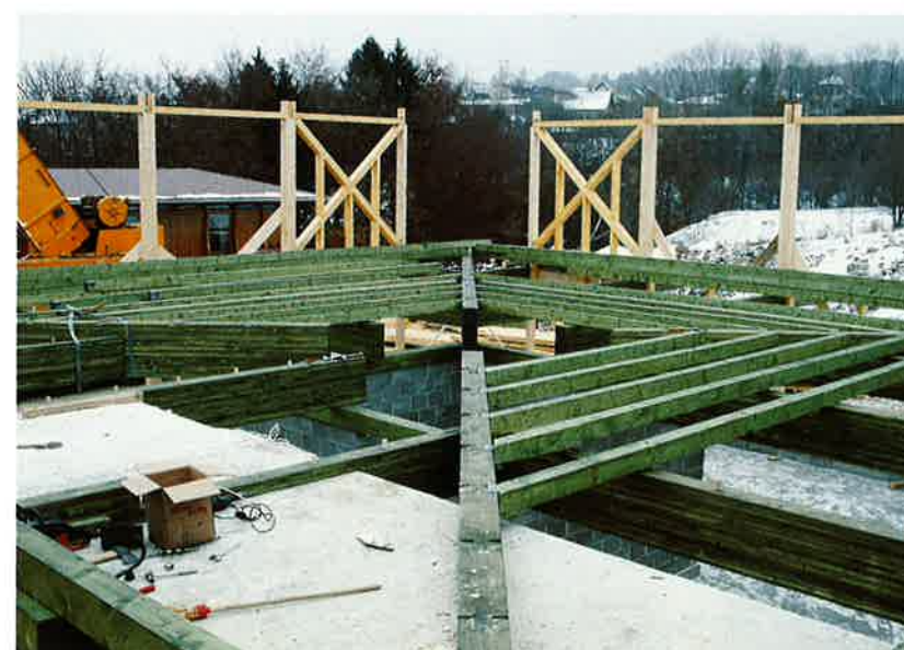
Vue d'ensemble des sommiers et de la poutraison sur le niveau inférieur. Montage des pans de bois.
