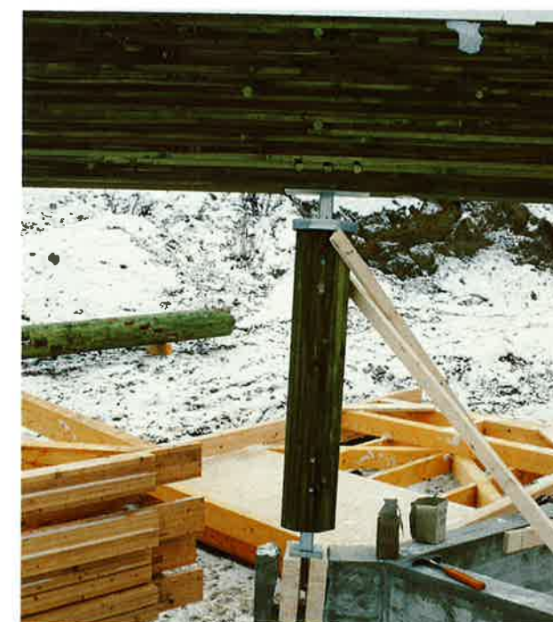
Vue d'ensemble des sommiers et de la poutraison sur le niveau inférieur. Montage des pans de bois.
