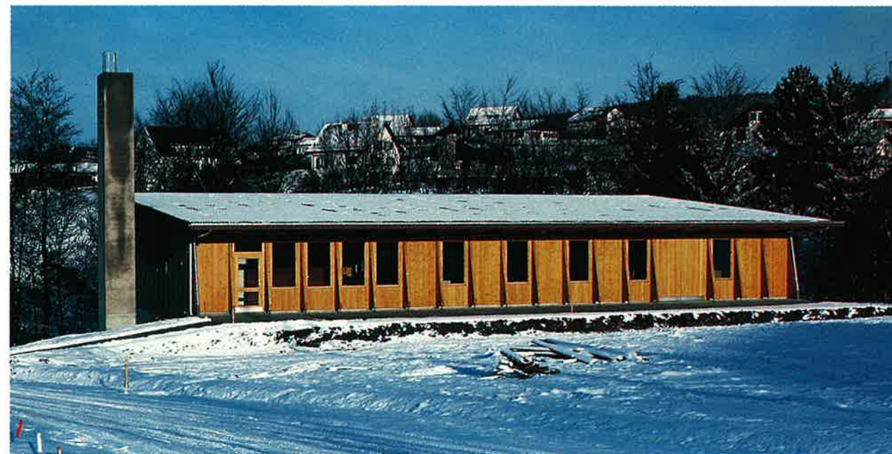
Première construction du programme d'intégration de la filière bois: le bâtiment de formation des forestiers-bûcherons sur le terrain donné au CEDOTEC par le Fonds paritaire vaudois FVE-FOBB.
