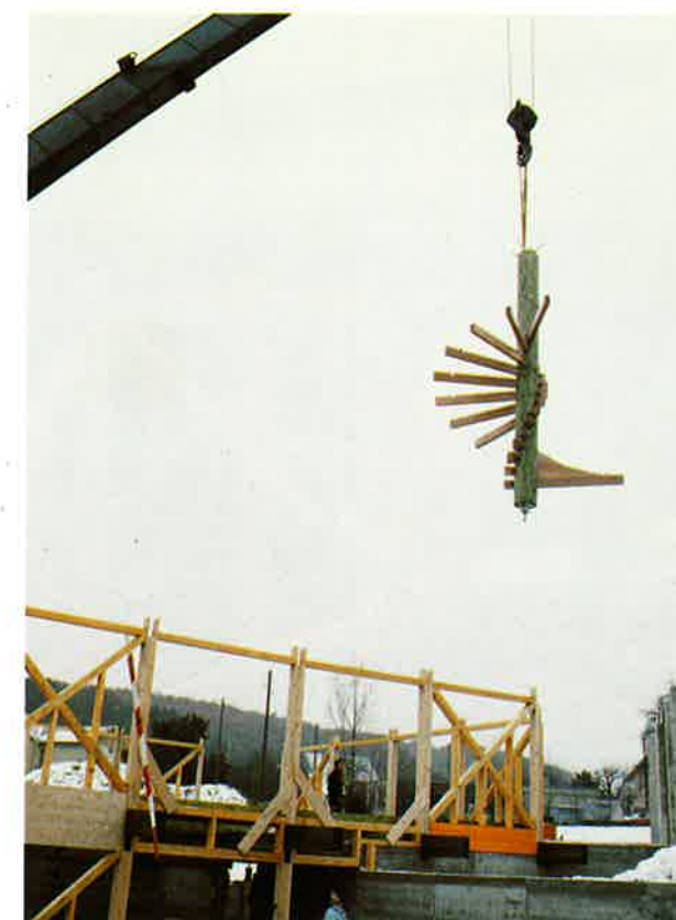
Levage et mise en place du support central destiné à recevoir les fermes de toitures.
