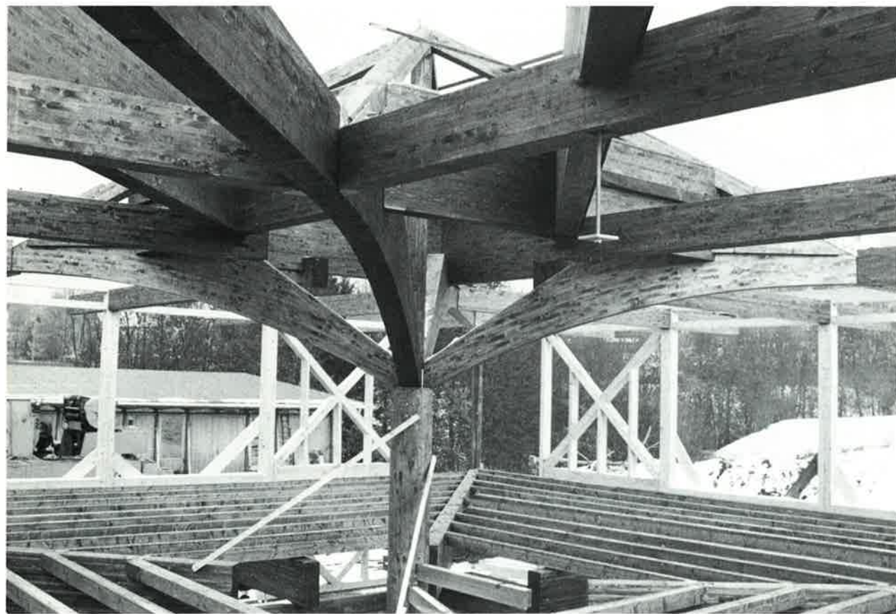
Nœud central avec les arêtières de traction.
