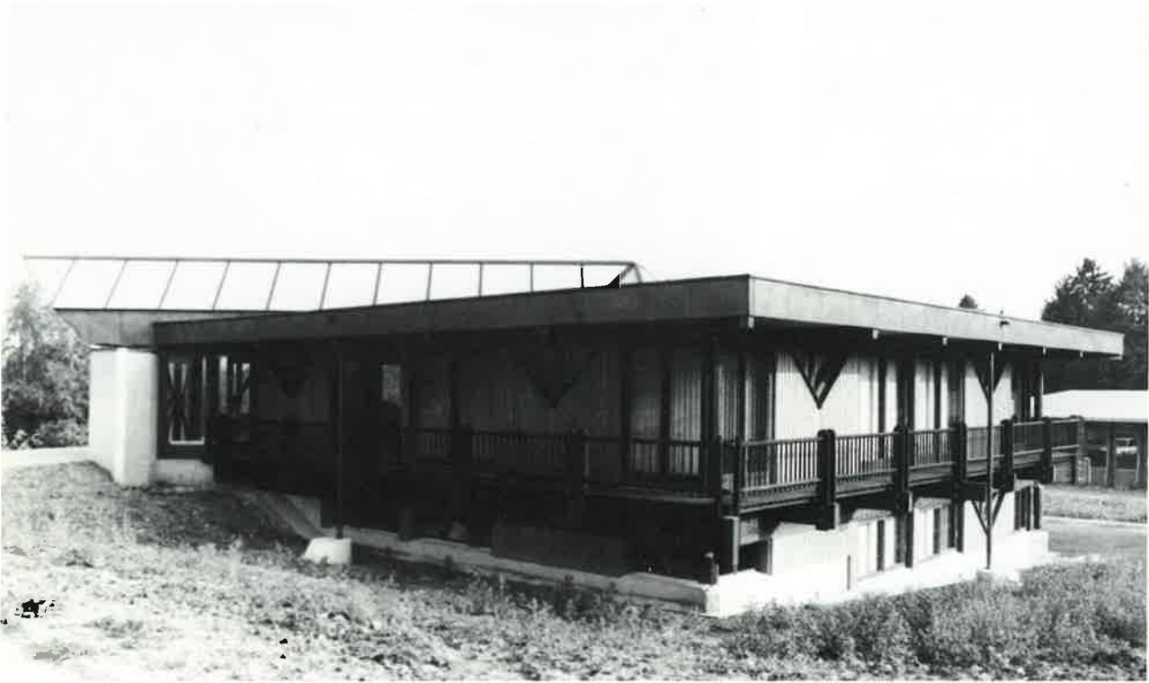
Vue d'ensemble du bâtiment côté amont.
