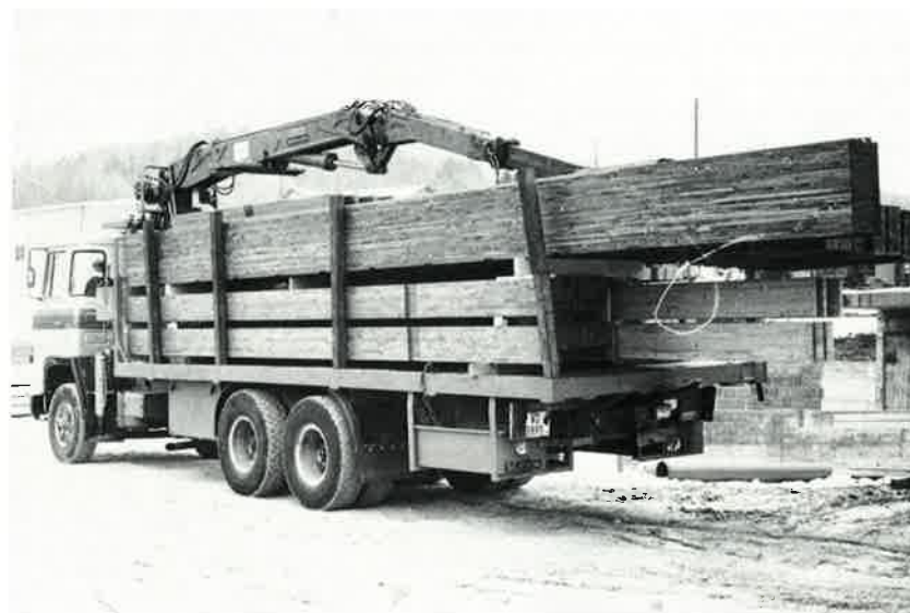
Ordonnancement des pièces préfabriquées sur la place de dépôt en fonction du montage.
