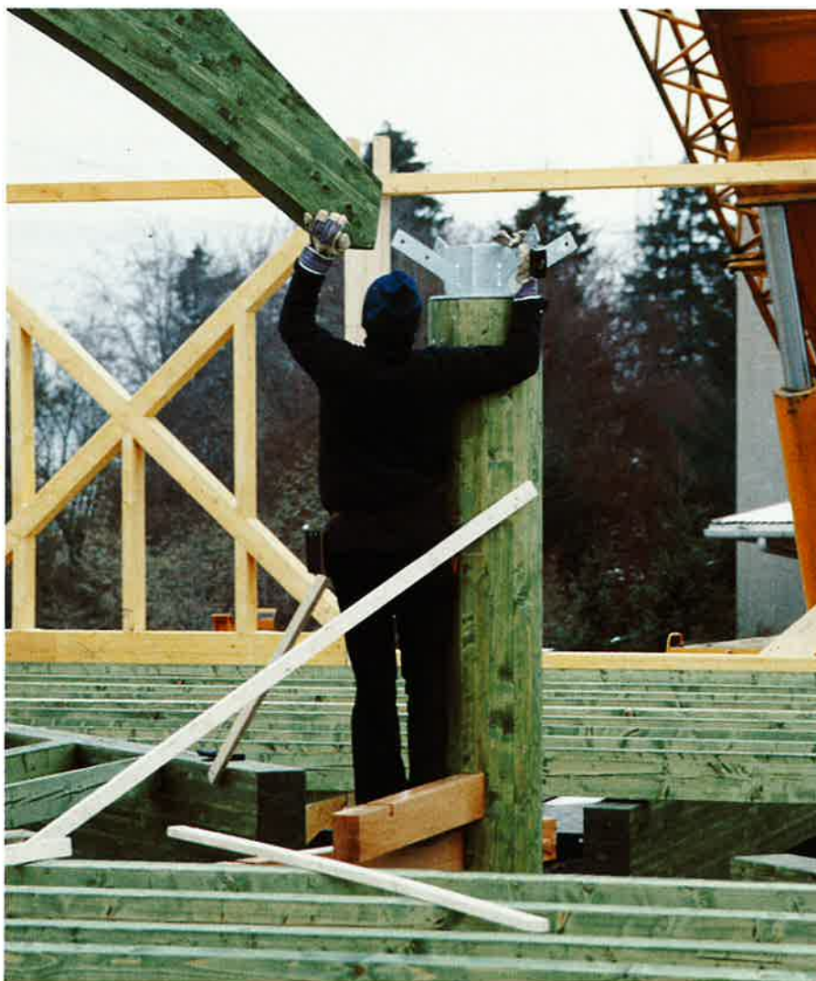
◀ Détail de fixation de la ferme sur le pilier central au moyen d'une ferrure chevillée.
