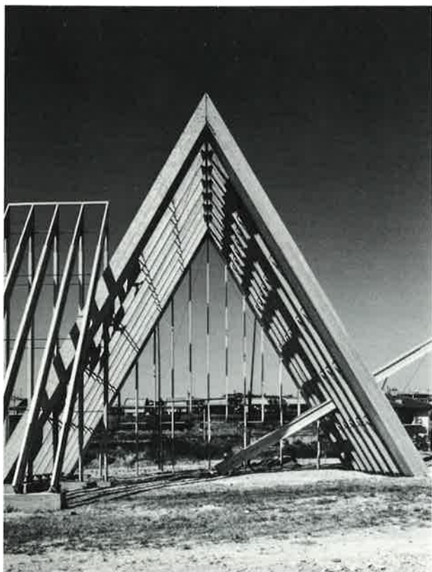
Les charpentiers de la Voie suisse de l'Exposition nationale 1964, une première manifestation d'une filière bois organisée.
